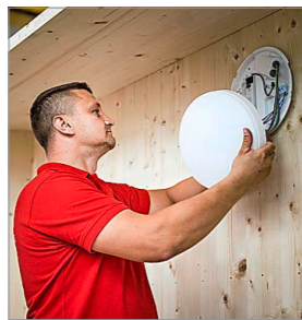
Vitalii Smoltc hilft beim Innenausbau der Wohncontainer.
